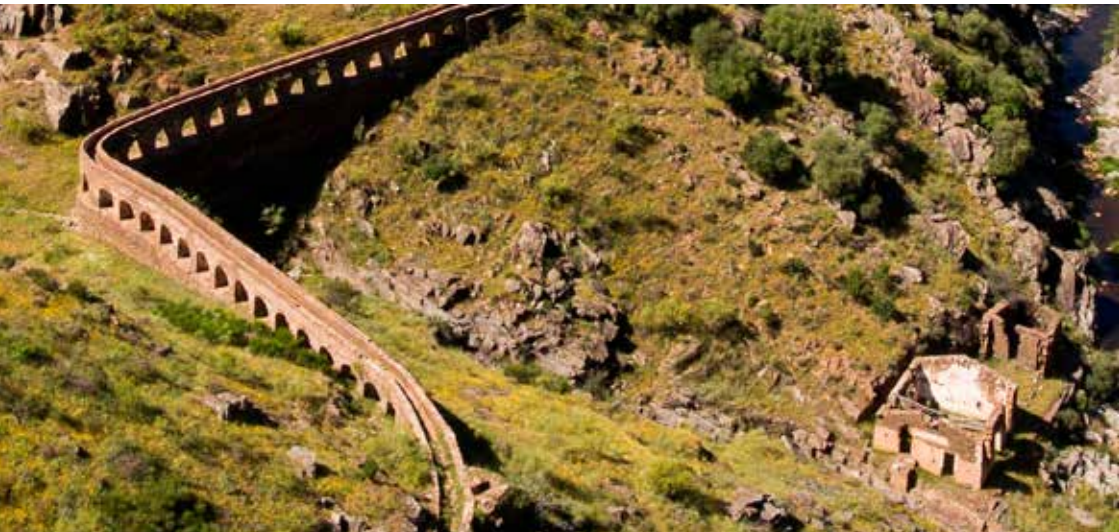
VISTA AÉREA DEL ACUEDUCTO DE LAS HERRERÍAS. (Campillo de Deleitosa)
