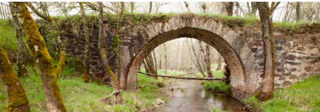
PUENTE DE LOS ÁLAMOS. (Inmediaciones de Guadalupe)
