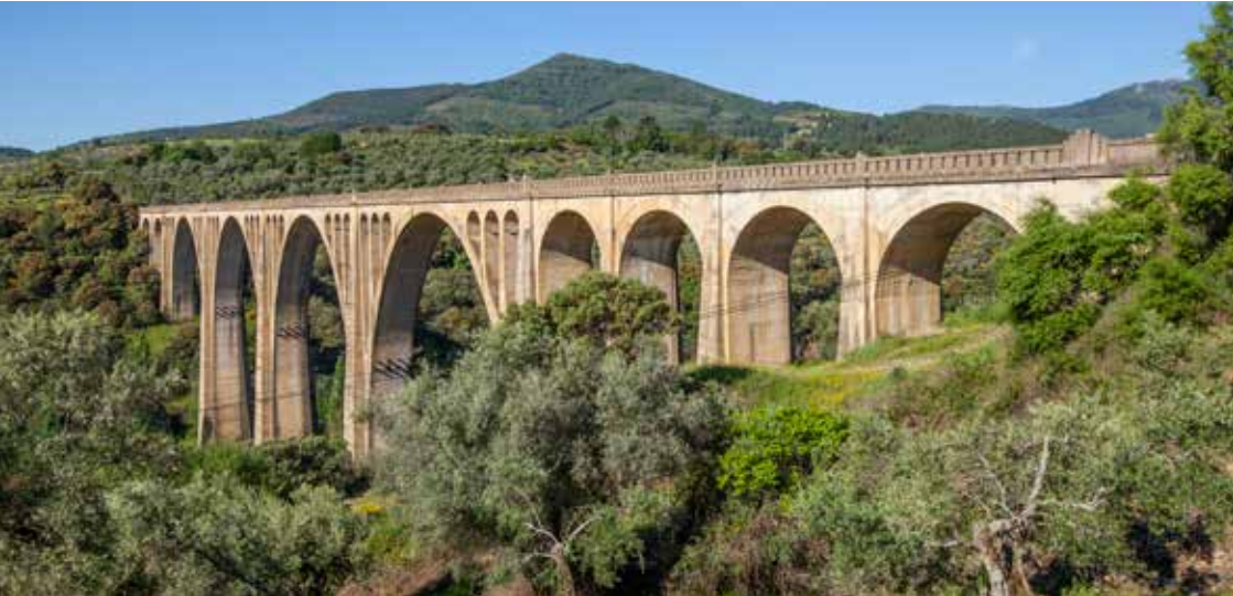
PANORÁMICA DEL VIADUCTO DE GUADALUPE
