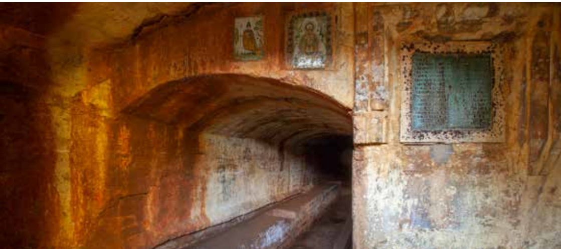
GALERÍAS DE CONDUCCIÓN DEL ARCA DEL AGUA. (Guadalupe)
